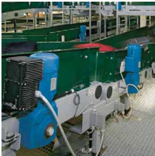
Distribucion de control
